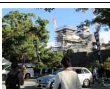
復旧工事中の熊本城
